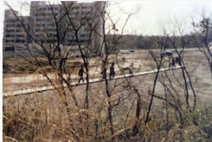
写真3 左：すずかけ台駅から246号線をくぐってのアプローチ（地獄谷）を横から見る。すでに埋め立ての段階で排水管工事が始まっている。写真右手が246号線とすずかけ台駅。左は精研低層棟（手前C棟と奥B棟）。 右：埋め立て中の迂回路と精研の建物を246号線の橋梁下辺りから見る。
