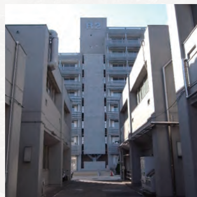
写真14 耐震改修後の精研 正面玄関は壊されておぼろげのとおりに耐震用コンクリートパネルとなった。廊下は反対側出口までが見通せる。
