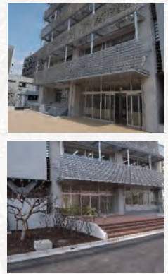
写真14 耐震改修後の精研 正面玄関は壊されておぼろげのとおりに耐震用コンクリートパネルとなった。廊下は反対側出口までが見通せる。
