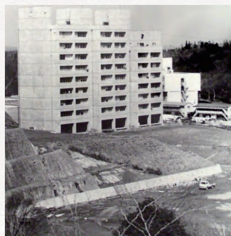
写真9 精研を西側から望む。まだ資源研(R1)も建っていないので、総合研究館(S1)の端壁壁面が丸見え。
