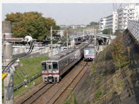
写真4 すずかけ台駅の昔と今 馬の背橋の上から見る。左は、複線化工事の最中で1976年ごろの写真。東急の赤帯8500系がとまっている。右は2003年撮影で、上り電車は東武電車、下り電車は営団電車
